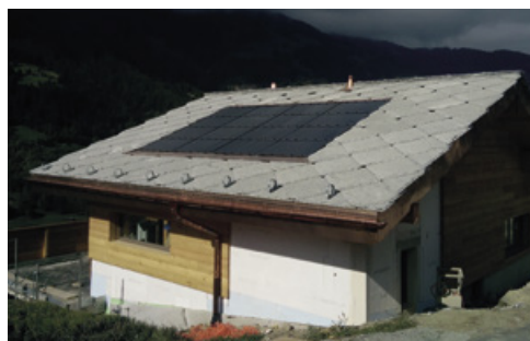
Chalet avec panneaux intégrés à une toiture en ardoise (3961 Vissoie)
