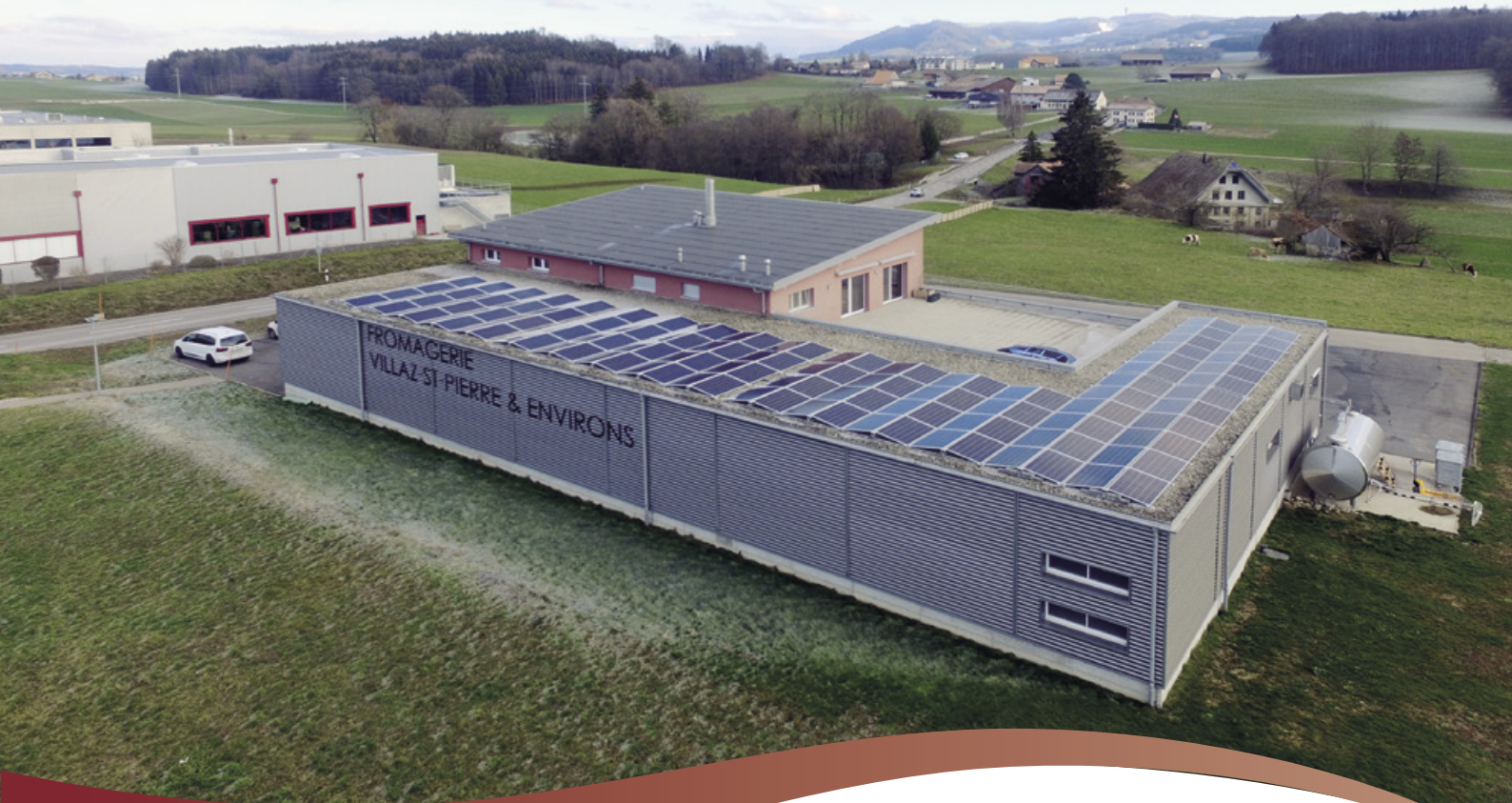
Fromagerie de Villaz-St-Pierre 44 kWc sur toiture plate
