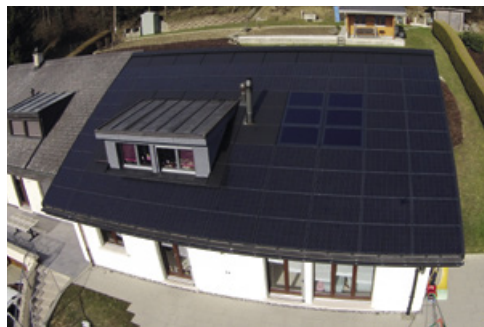
Villa dont la toiture a été totalement refaite avec des tuiles solaires Megaslate II (1670 Ursy)
