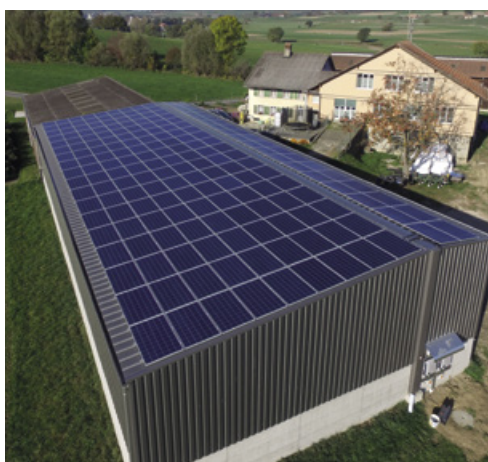
Halle agricole avec toiture en tôle trapézoïdale (1680 Romont)
