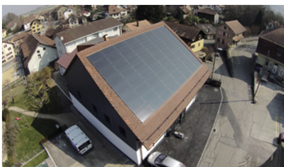
132 m 2 – 16 kWc 1523 Valbroye
