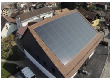
Bâtiment communal avec panneaux intégrés Solrif (1523 Valbroye)
