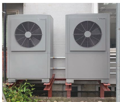
Cascade de 2 HRC 25 tri, avec module Premium Plus, 2740 Moutier
